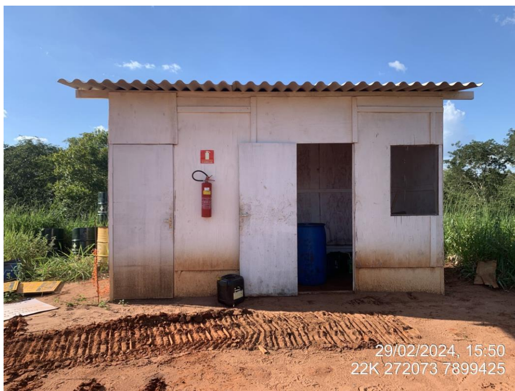
Figura 6-1. Central de resíduos sólidos temporária. PCH Fundãozinho, Paraíso das Águas, Mato Grosso do Sul. Fevereiro de 2024.
