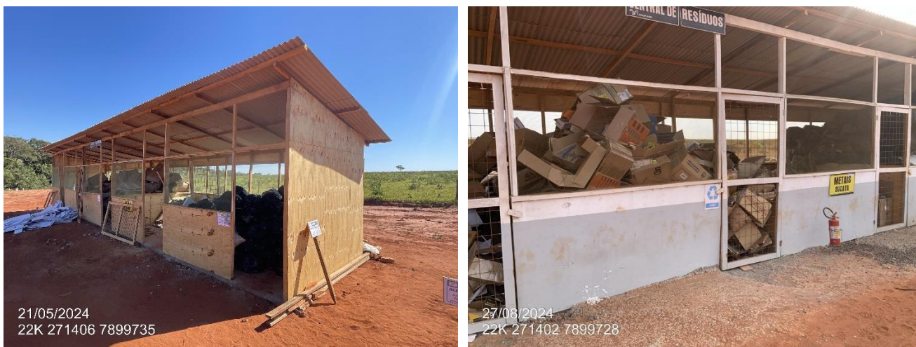
Figura 6-2. Central de armazenamento de resíduos sólidos. PCH Fundãozinho, Paraíso das Águas, Mato Grosso do Sul. Maio e agosto de 2024.
