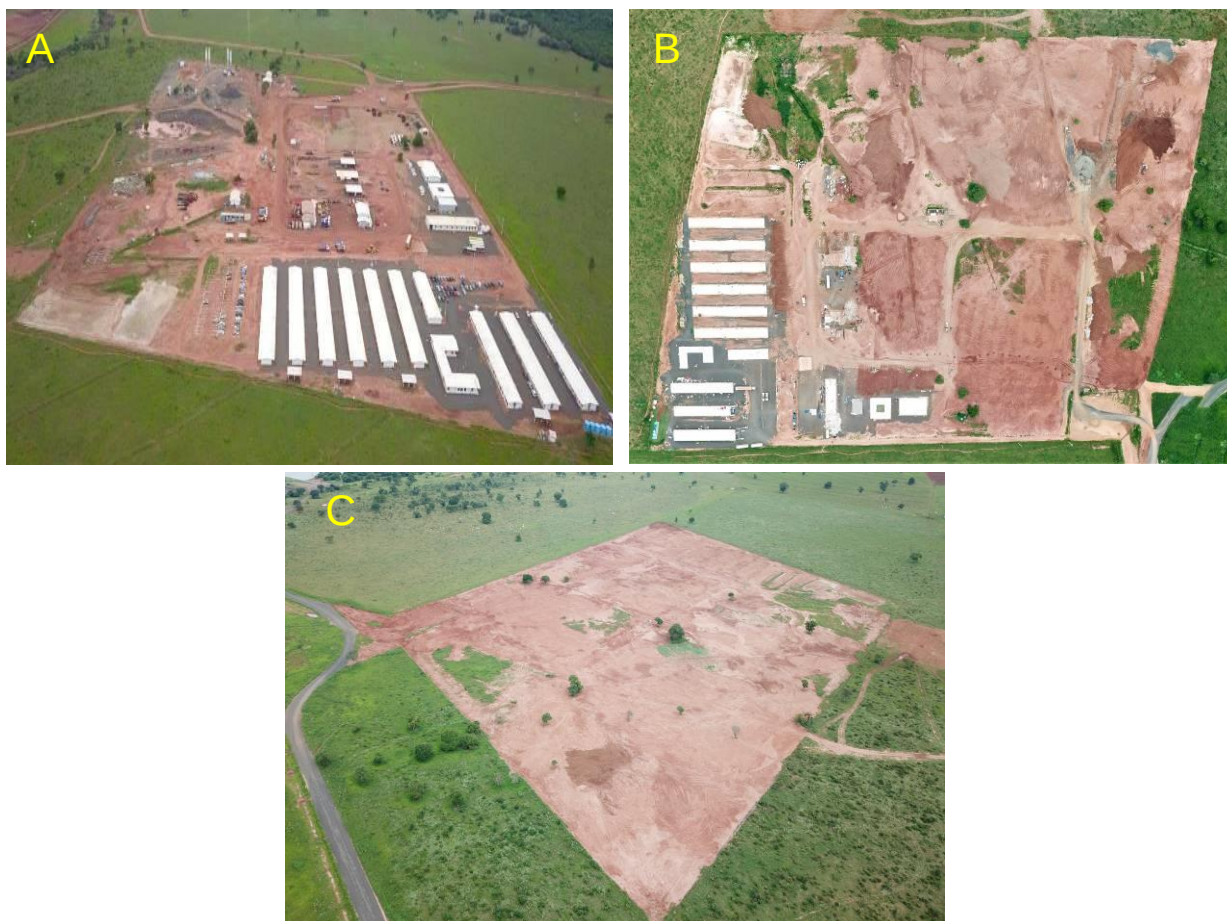
Figura 3. Área destinada ao canteiro de obras em 2018 (A), área durante o processo de desmobilização em 2019 (B) e a área desmobilizada (C). Fonte: Rio Água Clara Energia, 2018 e 2019.
