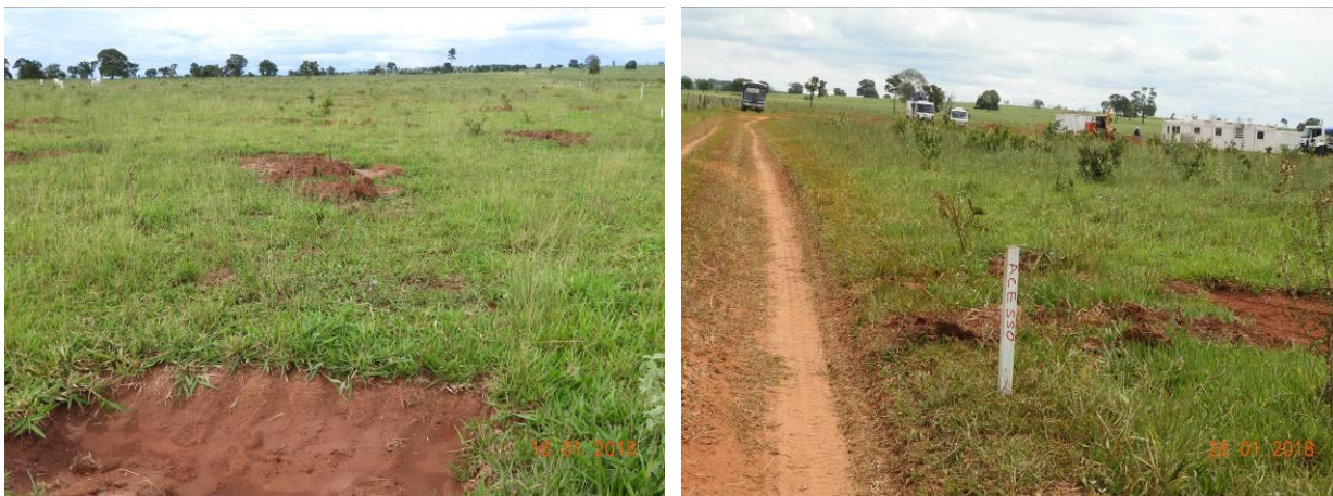
Figura 2. Área destinada ao canteiro de obras e início de mobilização em 2018. Fonte: Samorano Consultoria Ambiental, 2018.
