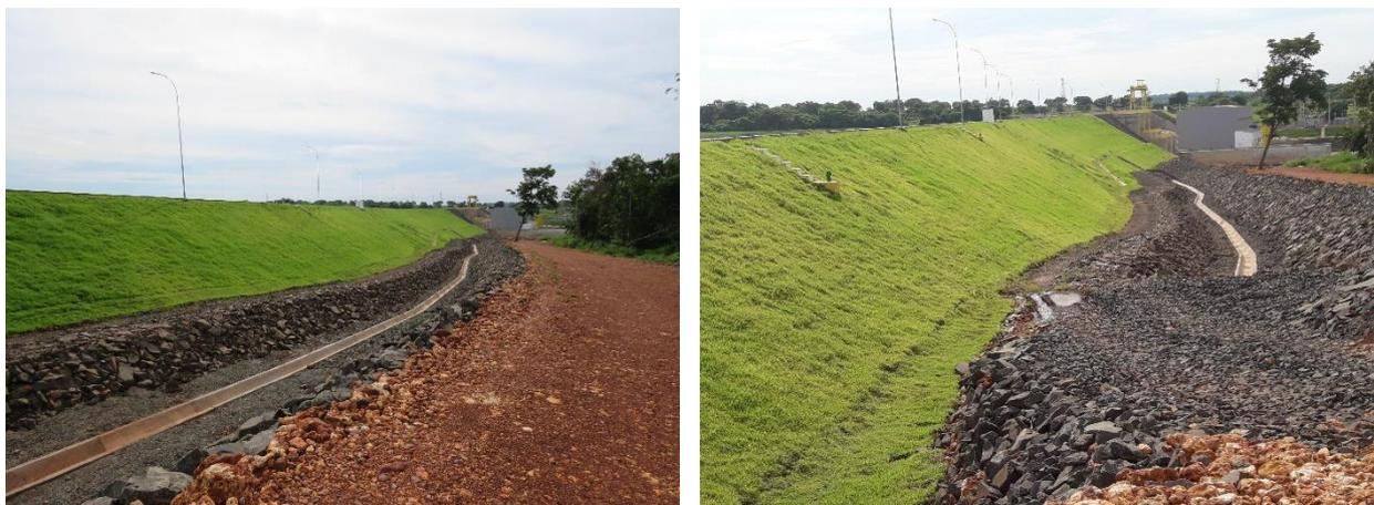
**Figura 4.** Enrocamento e cobertura vegetal na margem direita da barragem na PCH Bandeirante. Fonte: Samorano Consultoria Ambiental, 2020.
