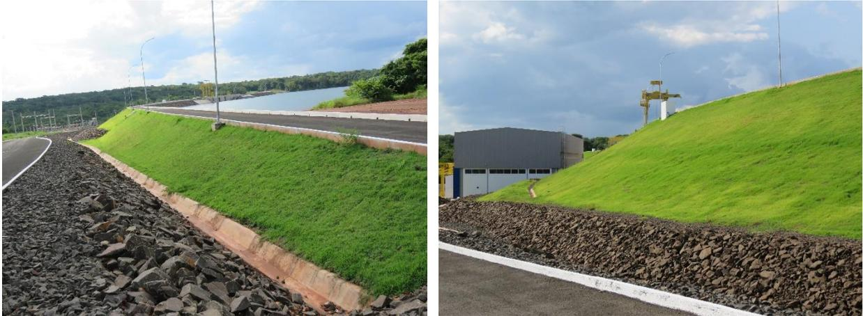
**Figura 5.** Enrocamento e cobertura vegetal na margem esquerda da barragem na PCH Bandeirante. Fonte: Samorano Consultoria Ambiental, 2020.
