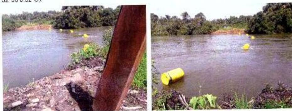
**Figura 11.** Vista de Log Boom instalado à jusante da PCH Areado (Coordenadas: 19°32'53.16"S / 52°30'20.86"O).
