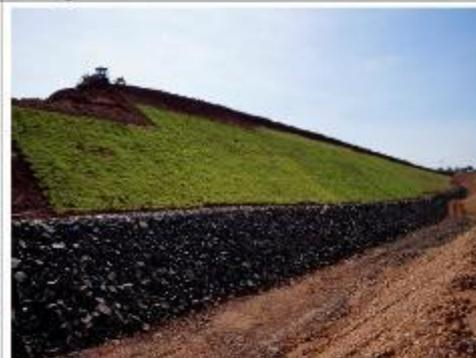
Foto 08: Conforme avanços do alçamento da barragem é o avanço do plantio das placas das gramas.
