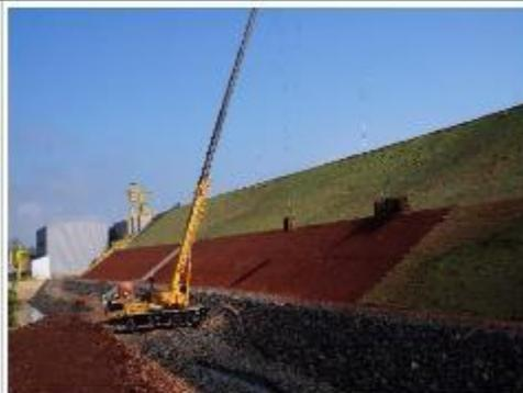
Foto 06: Vista da barragem ME em andamento do plantio das placas de gramas em berma da barragem.
