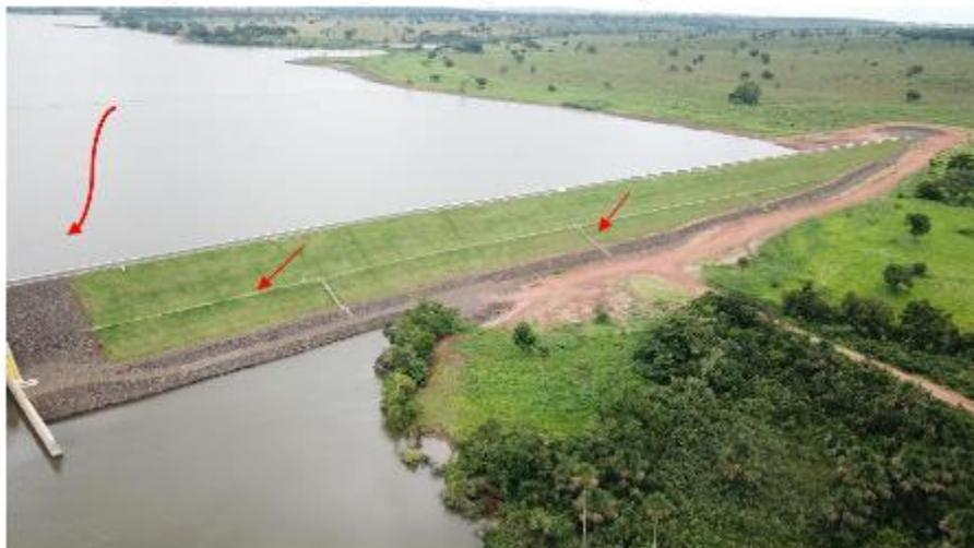
Foto 04: Vista para barramento ML, detalhe no plantio de grama e canalota da bermã.
