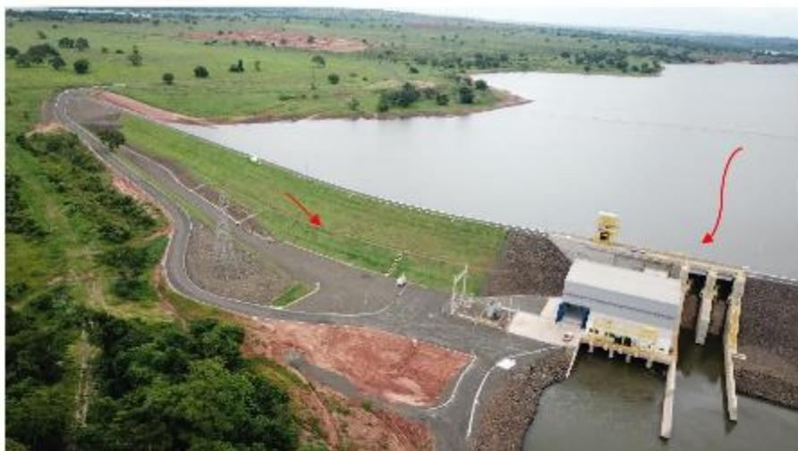
Foto 03: Vista para barramento MD, detalhe no plantio de grama e canaleta da berma.
