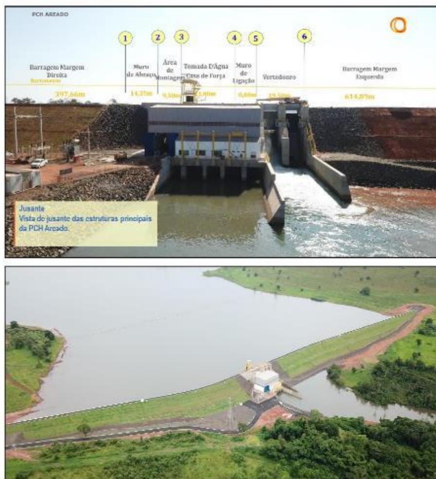
Foto 01: Vista geral das estruturas e suas dimensões. / Foto 02: Vista geral p/ jusante da PCH.
