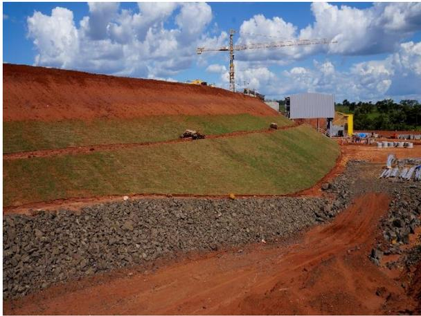
Foto 09: Vista do andamento / aplicação das placas de grama, berma e crista do barramento.
