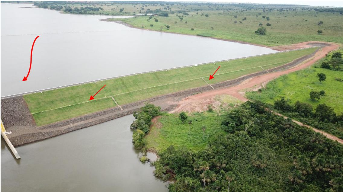
Foto 04: Vista para barramento ME, detalhe no plantio de grama e canaleta da berma.
