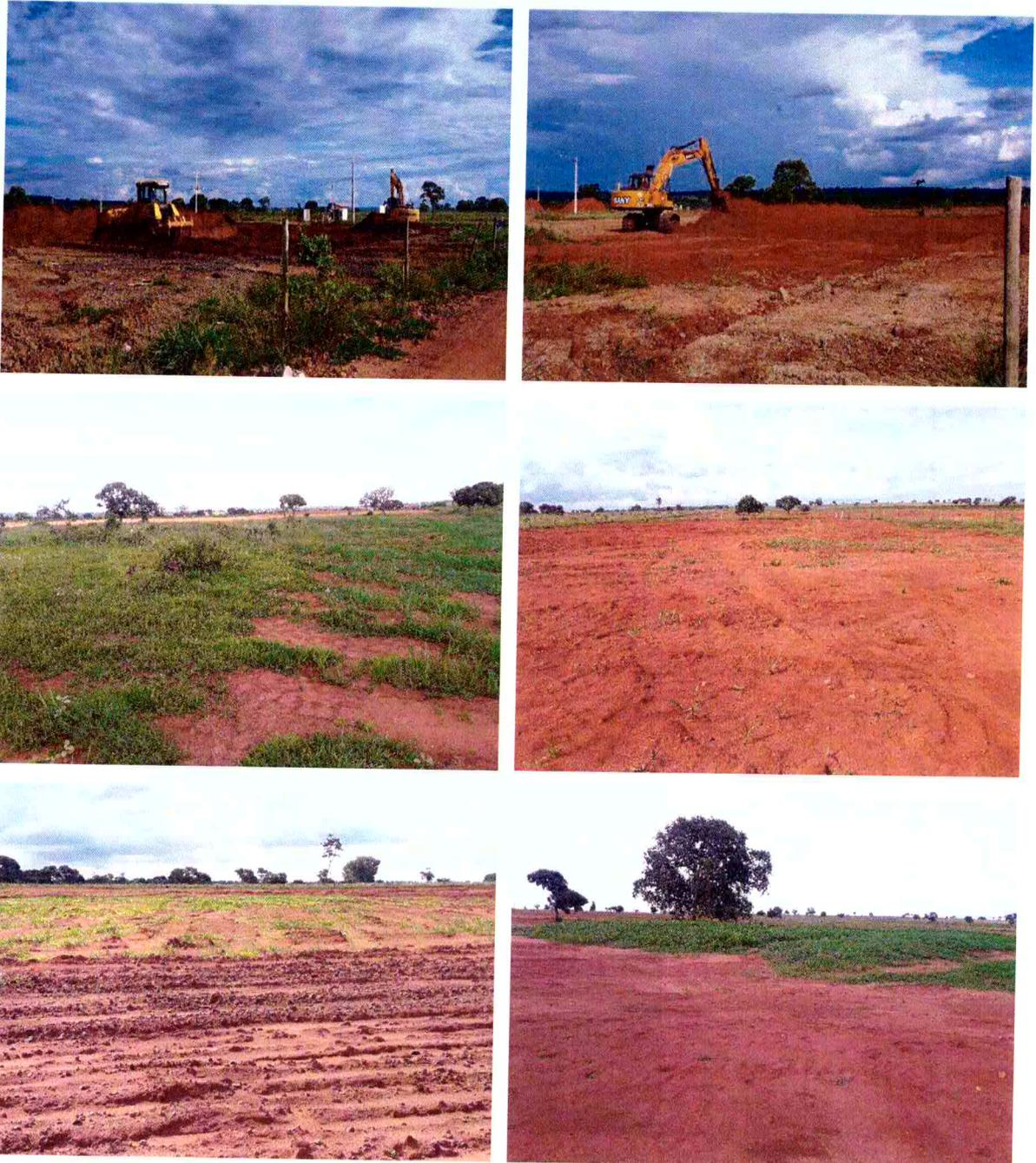
**Figura 5.** Desmobilização e recuperação do canteiro de obras (Coordenadas: 19°32'2.58"S / 52°30'26.97"O).
