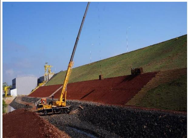
Foto 06: Vista da barragem ME em andamento do plantio das placas de gramas em beirada da barragem.
