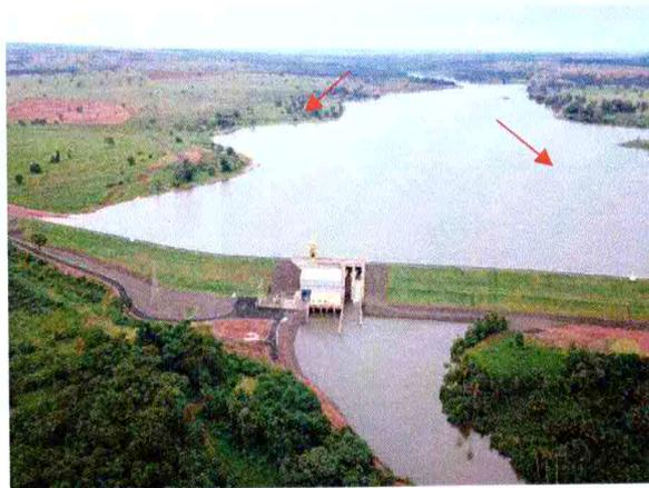
**Figura 4.** Áreas de bota fora após o enchimento do reservatório.
