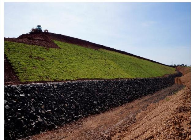
Foto 08: Conforme avanços do alteamento da barragem é o avanço do plantio das placas das gramas.
