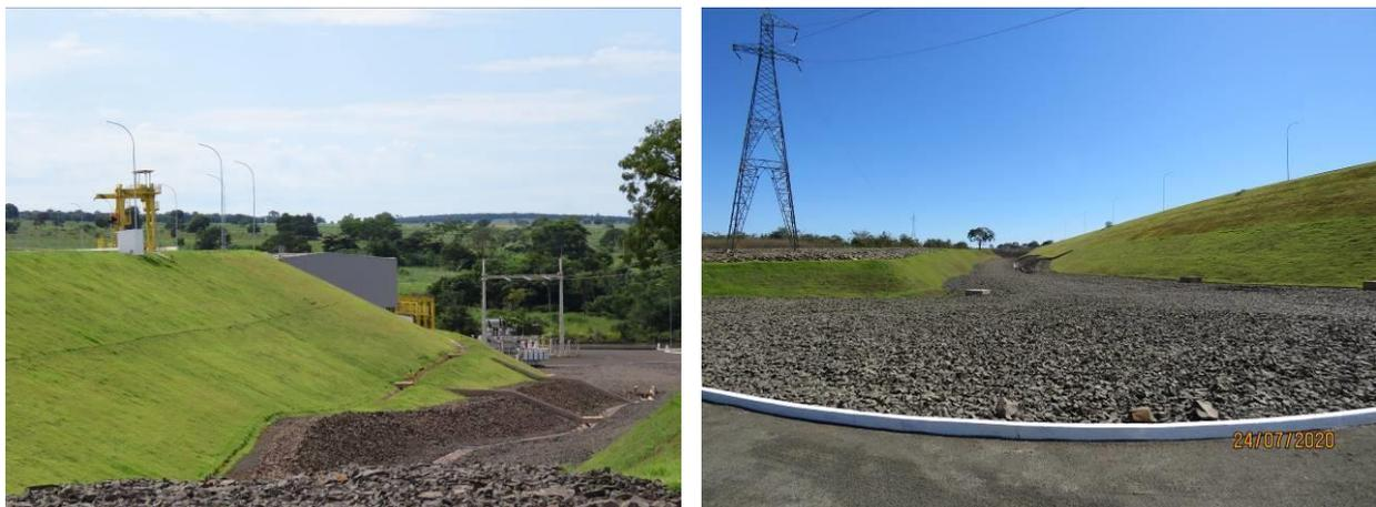
**Figura 10.** Enrocamento e cobertura vegetal na margem direita da barragem na PCH Areado. Fonte: Samorano Consultoria Ambiental, 2020.
