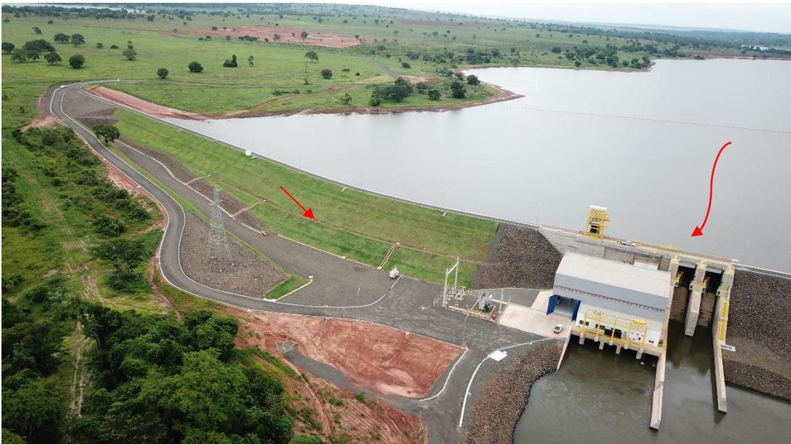
Foto 03: Vista para barramento MD, detalhe no plantio de grama e canaleta da berma.
