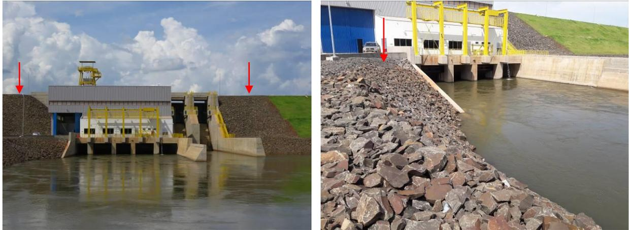
**Figura 9.** Enrocamento externo para proteção do Rio Indaiá Grande a jusante da PCH Areado, município de Chapadão do Sul e Inocência. Fonte: Samorano Consultoria Ambiental, 2020.
