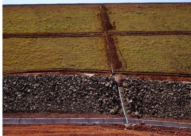
Foto 07: Detalhe na instalação da irrigação embutida.
