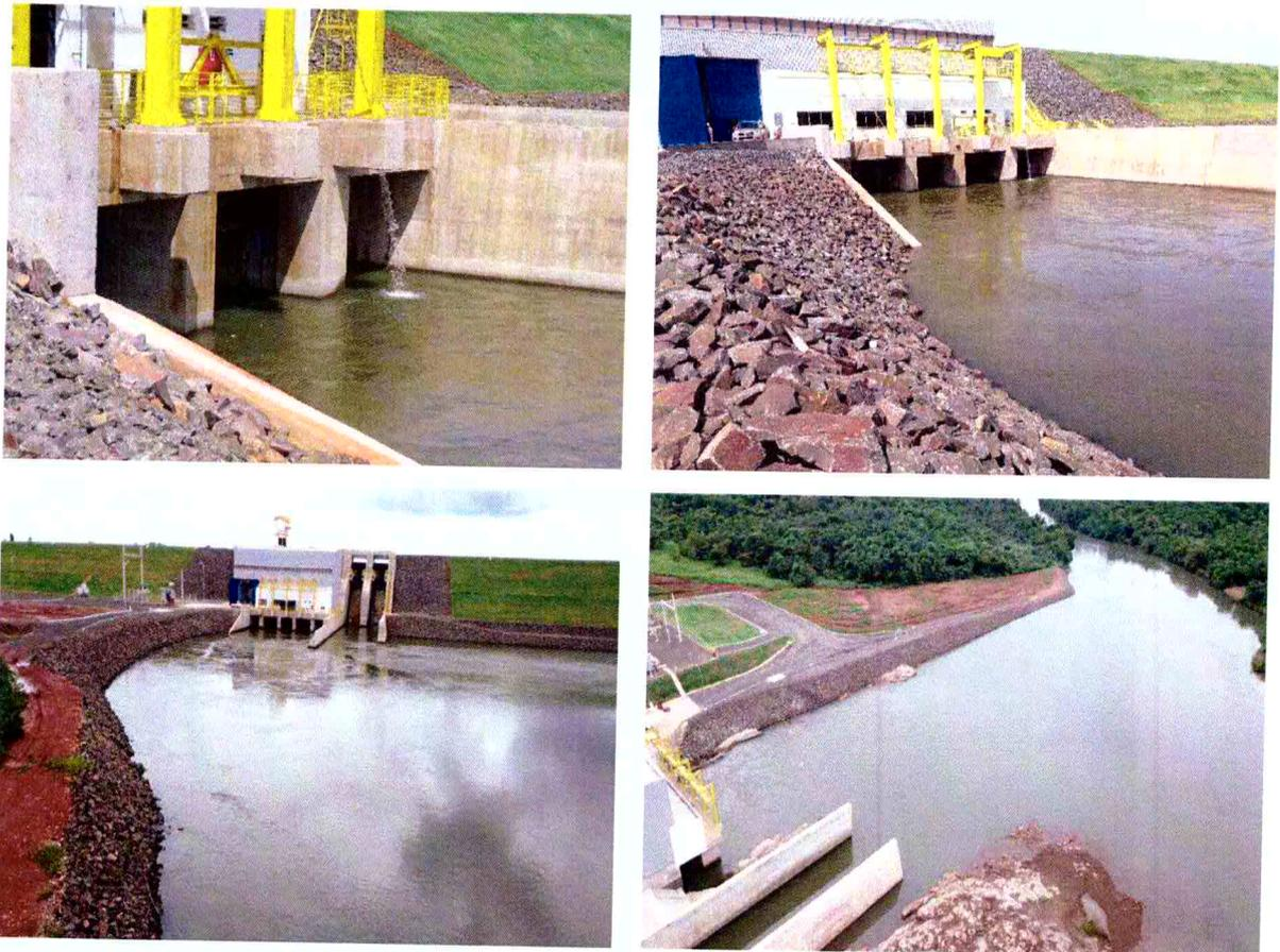
**Figura 9.** Vista de enrocamento no canal de fuga da PCH Areado (Coordenadas: 19°32'44.23"S / 52°30'20.13"O).
