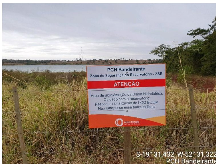
Figura 16.3.1-4: Sinalização implantada na Zona de Segurança do Reservatório-ZSR da PCH Bandeirante, Água Clara, Mato Grosso do Sul.
